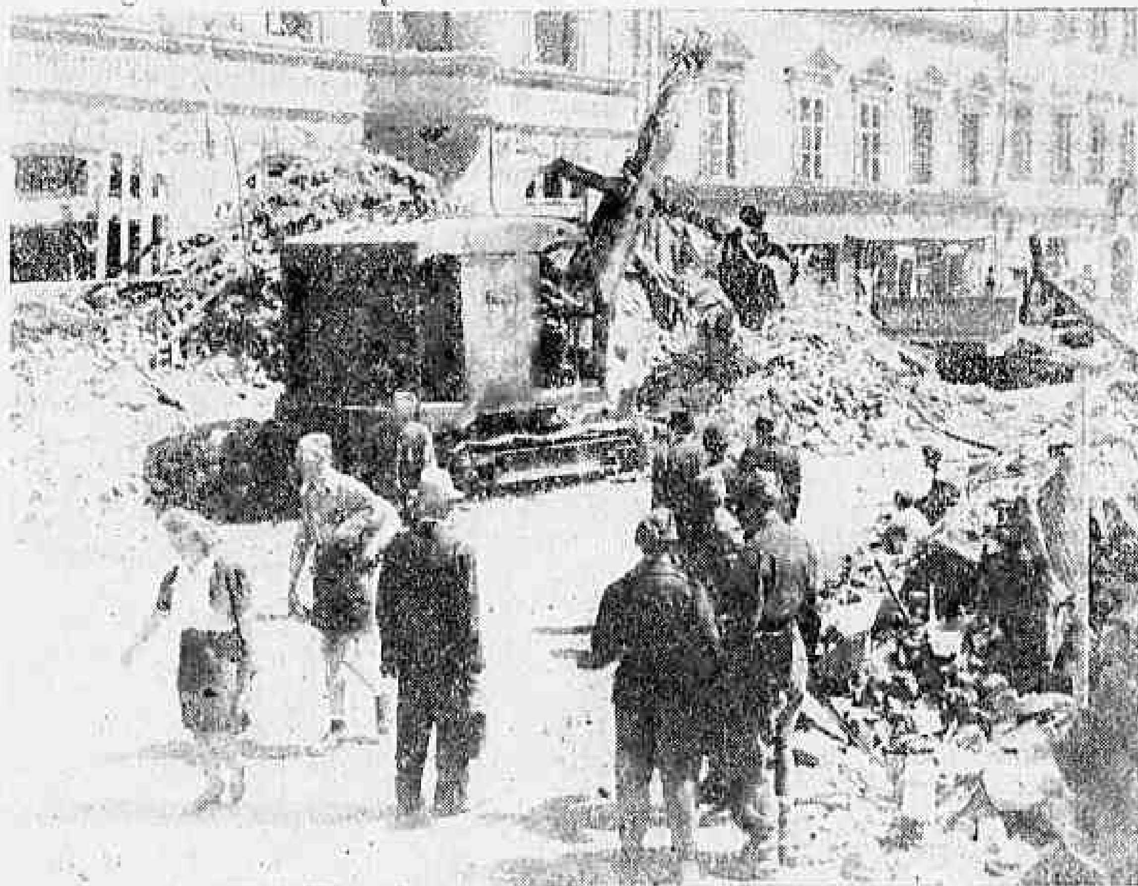
Ein Bagger der englischen Armee bei Aufräumarbeiten in den Straßen von Klagenfurt.
