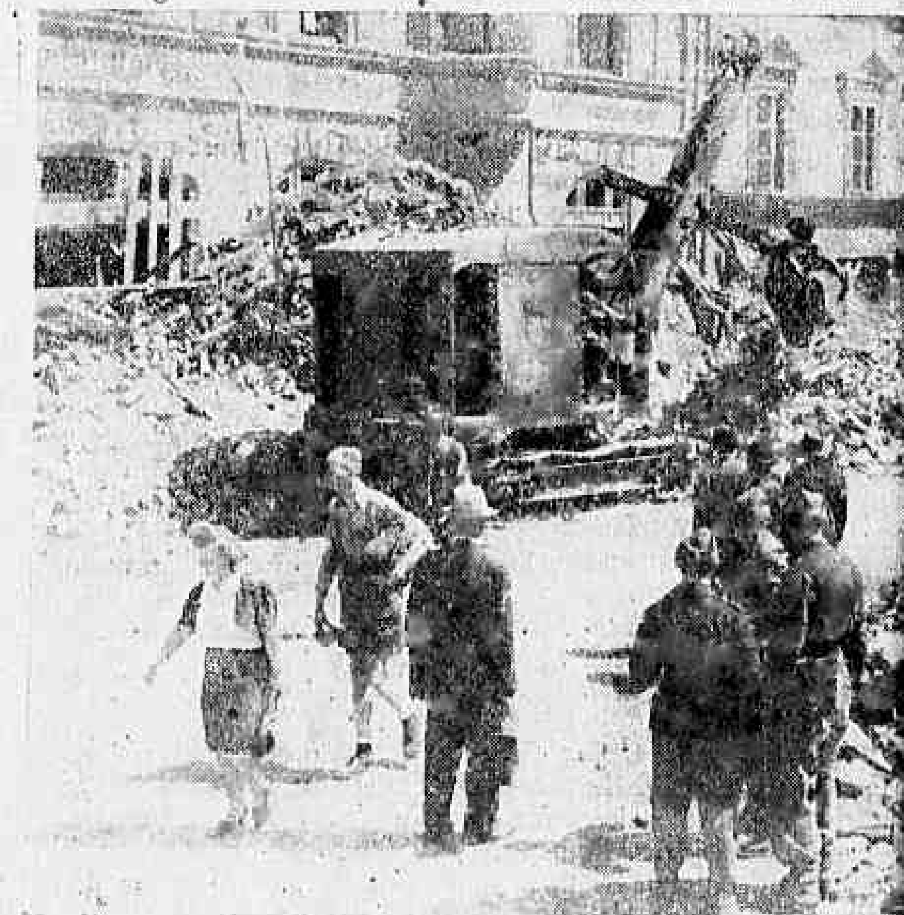
Ein Bagger der englischen Armee bei Aufräumarbeiten Klagenfurt.
