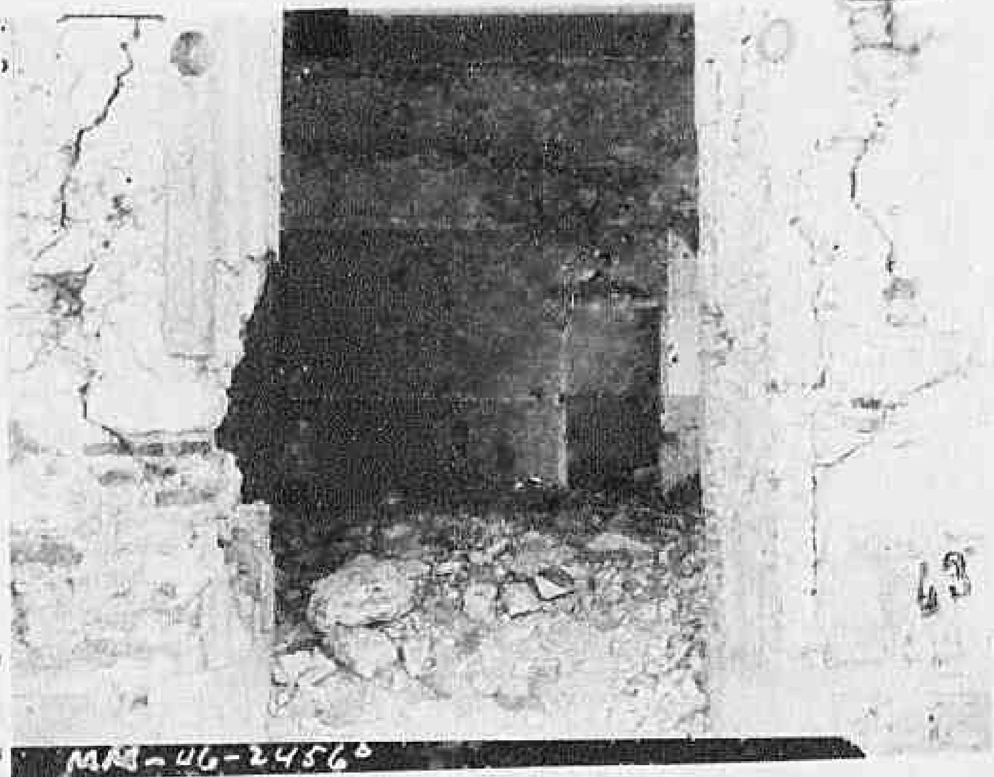
Internal view on Via D'Alberto PARTICOLARE ENTRATA VISTA DA VIA D'ALBERTO
