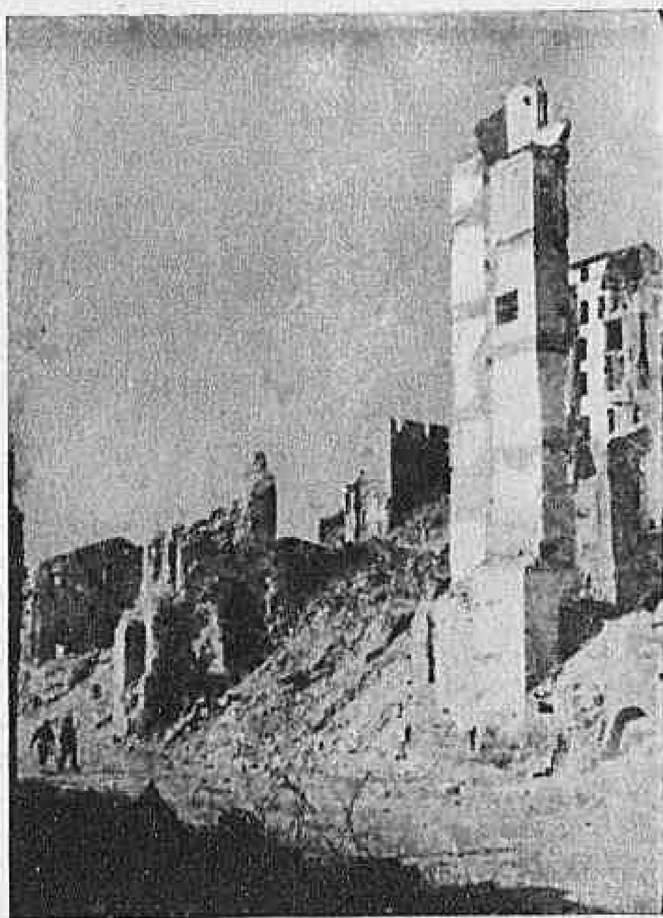
Fig. 7 - ANCONA - Distruzioni nel quartiere Porto, in corrispondenza dell'ultimo tratto di Via Saffi.
