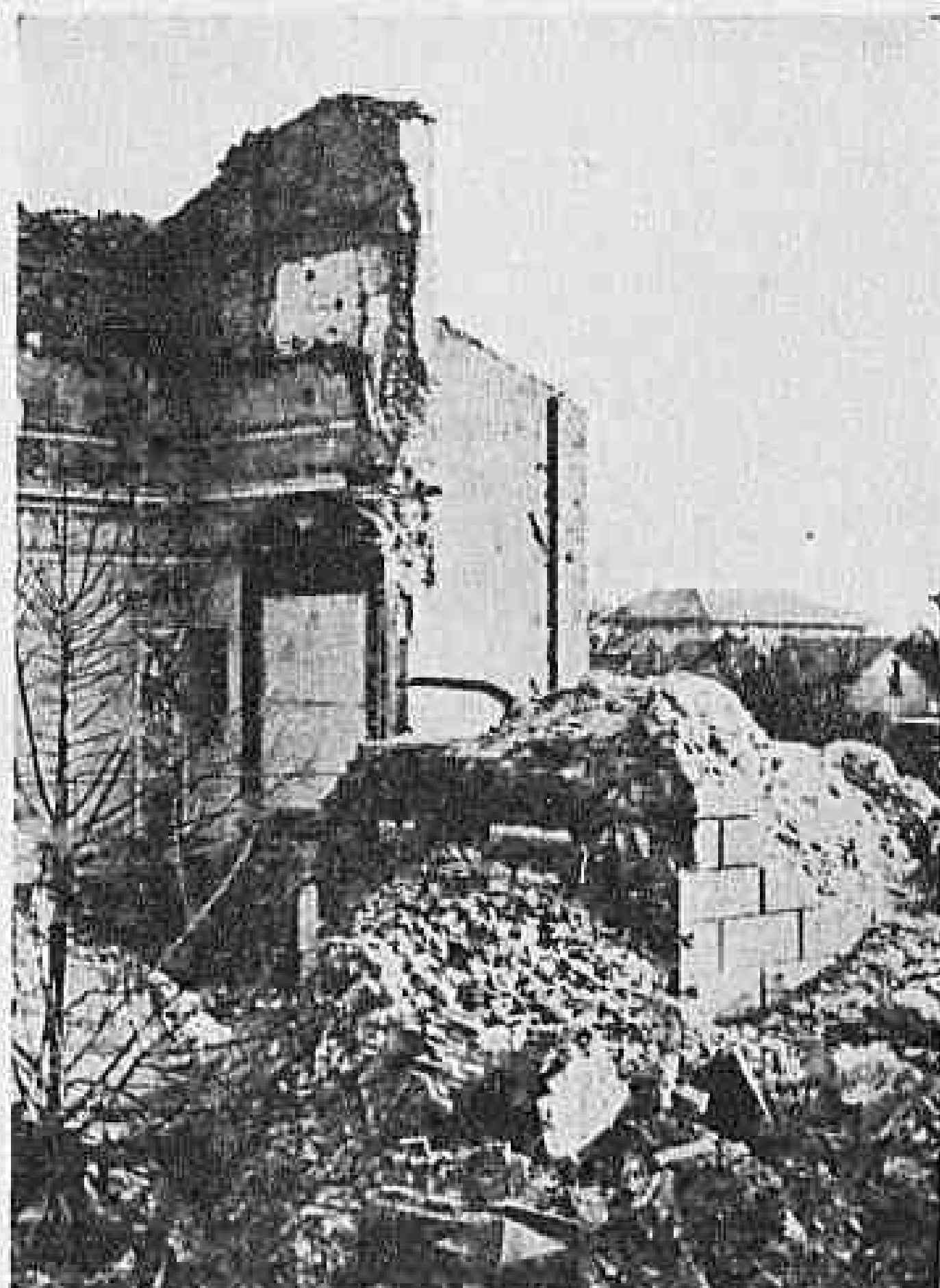
Fig. 11 - FANO - La chiesa di S. Maria Nuova dopo la caduta del campanile che travolse il coro.
