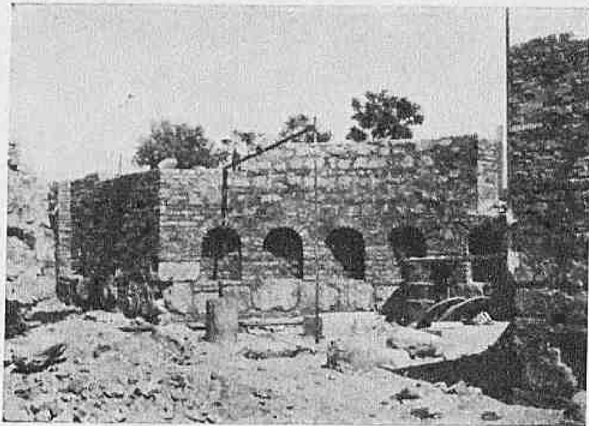
Fig. 19 - ANCONA - Duomo: ricostruzione dell'abside della cripta del Crocifisso. I blocchi di tufo del primo filare sono stati ricollocati ciascuno al proprio posto; la muratura al disopra è stata ricostruita in mattoni.
