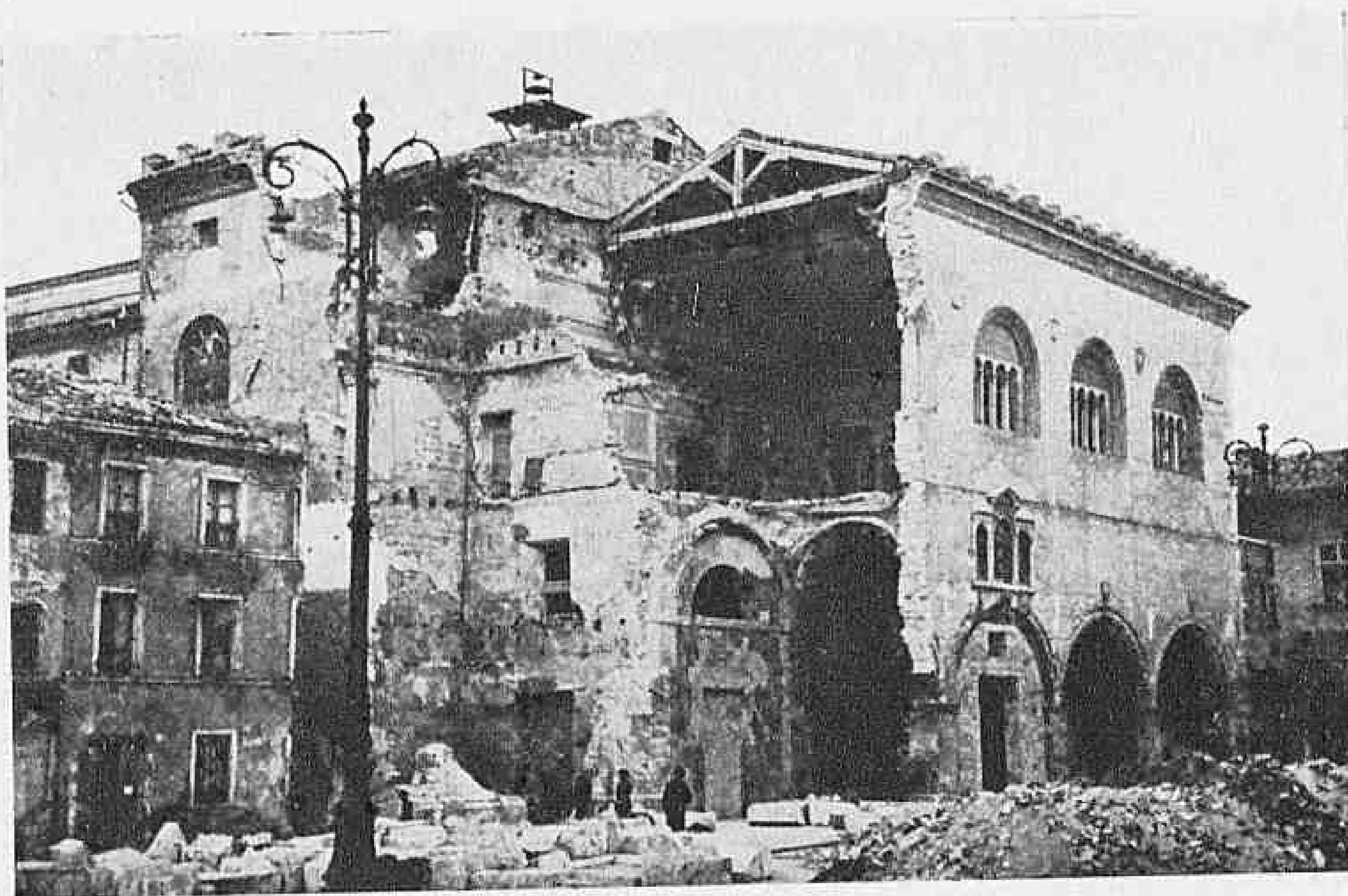
Fig. 12 - FANO - I resti del Palazzo della Ragione dopo il crollo della torre angolare.
