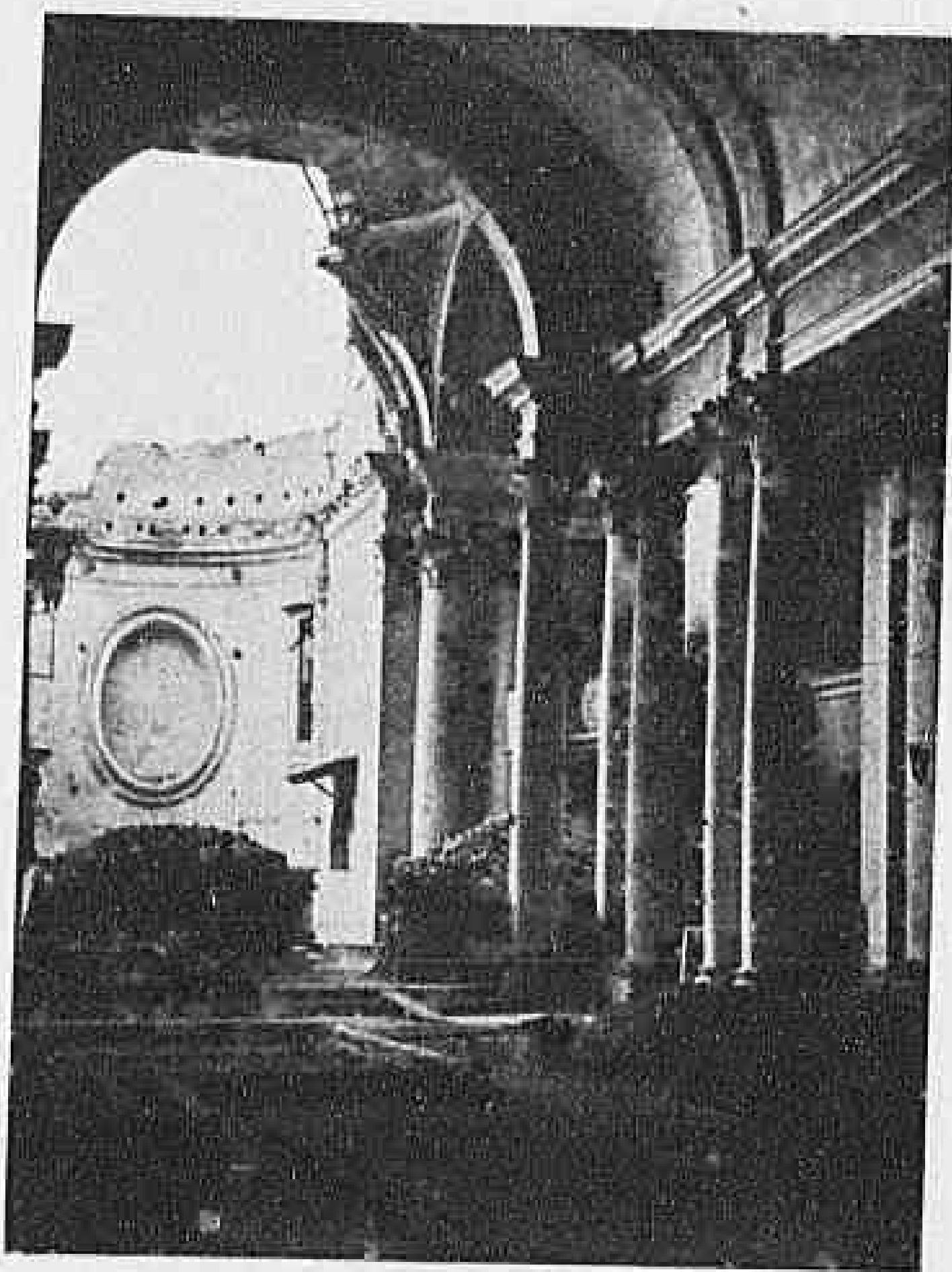
Fig. 17 - FANO - La chiesa di San Domenico dopo lo sgombero delle macerie. Sull'arco contenente l'affresco del sepolcro De' Pili è stato costruito un provvisorio tettino di protezione.
