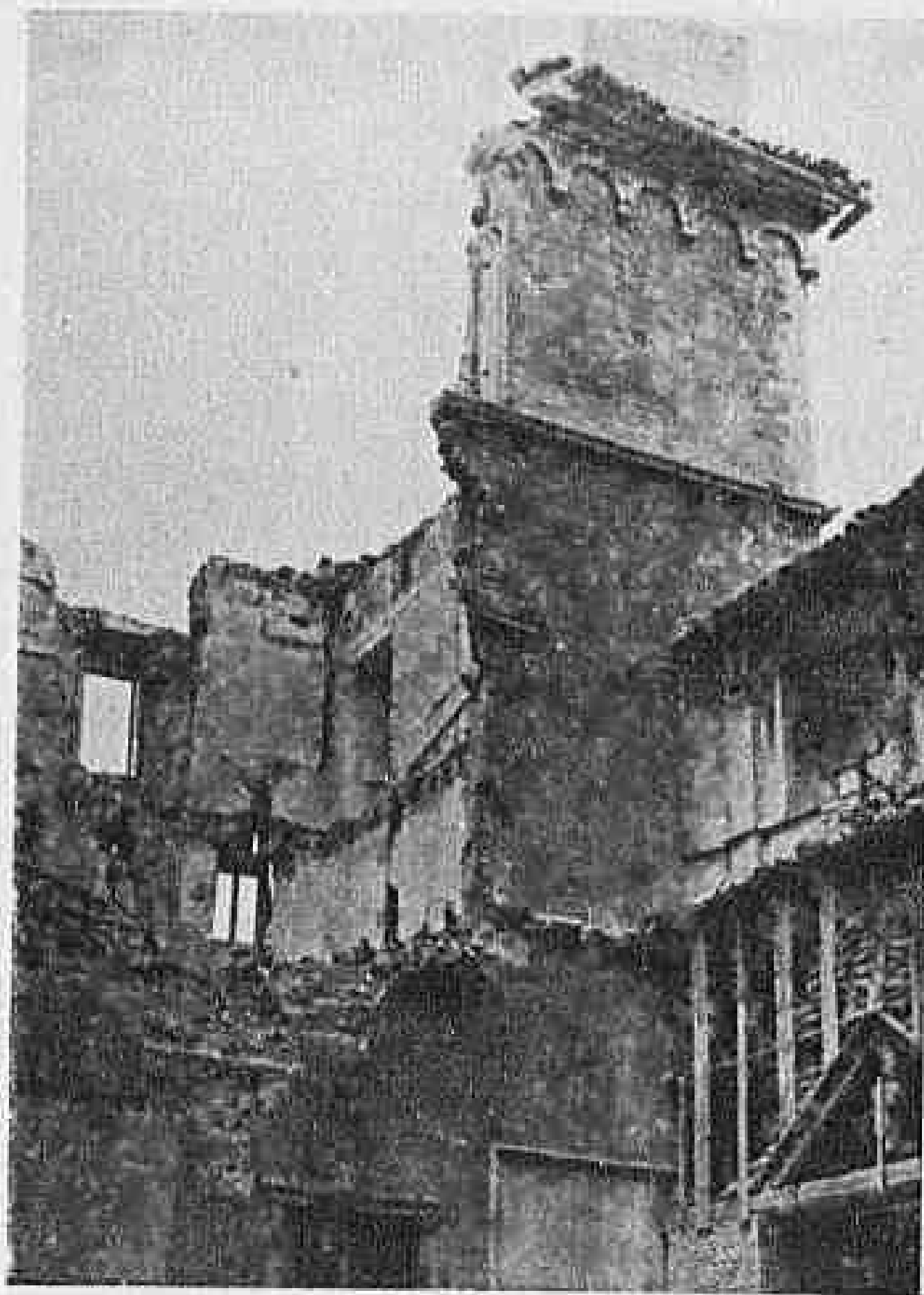
Fig. 10 - ANCONA - La parete verso il cortile del Palazzo degli Anziani dopo il bombardamento del 1° nov. 1943.
