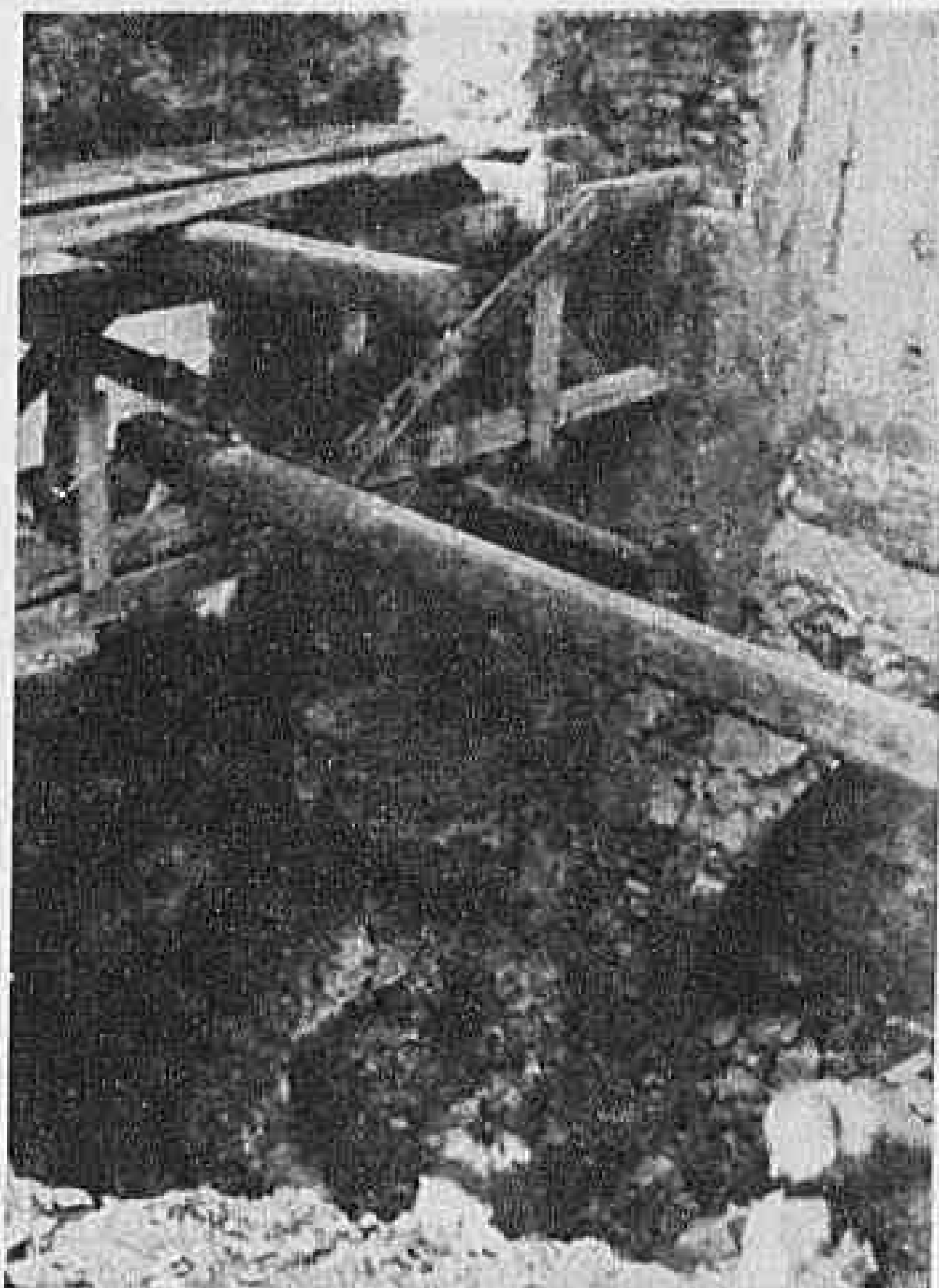
Fig. 22 - ANCONA - Palazzo degli Anziani: la trave composta di puntellamento della breccia sulla parete a monte durante la ricostruzione.
