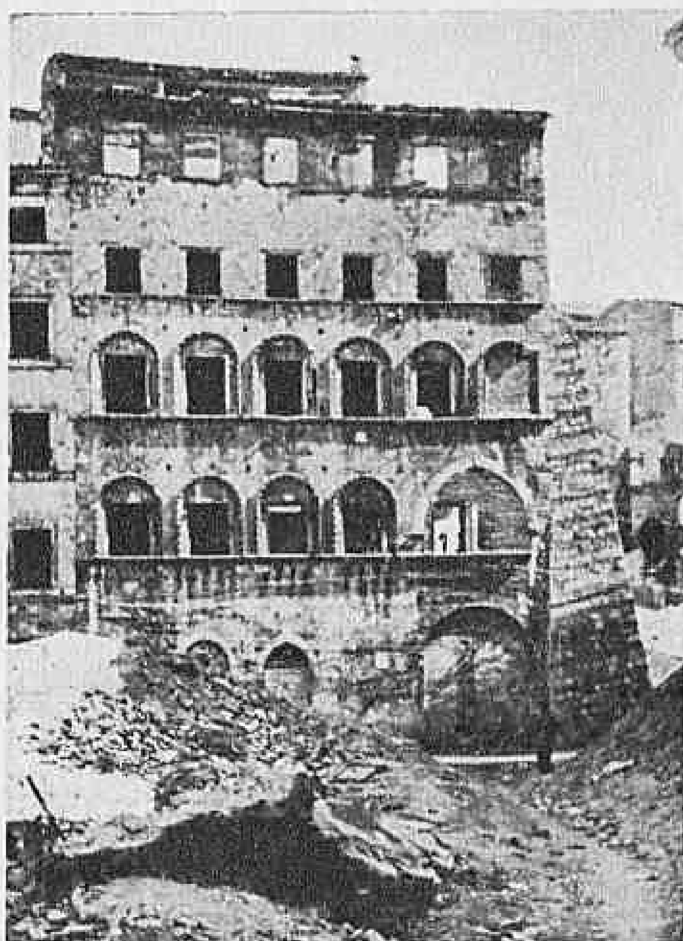
Fig. 13 - ANCONA - Lo sperone di sostegno provvisorio della facciata del Palazzo del Senato anconetano.
