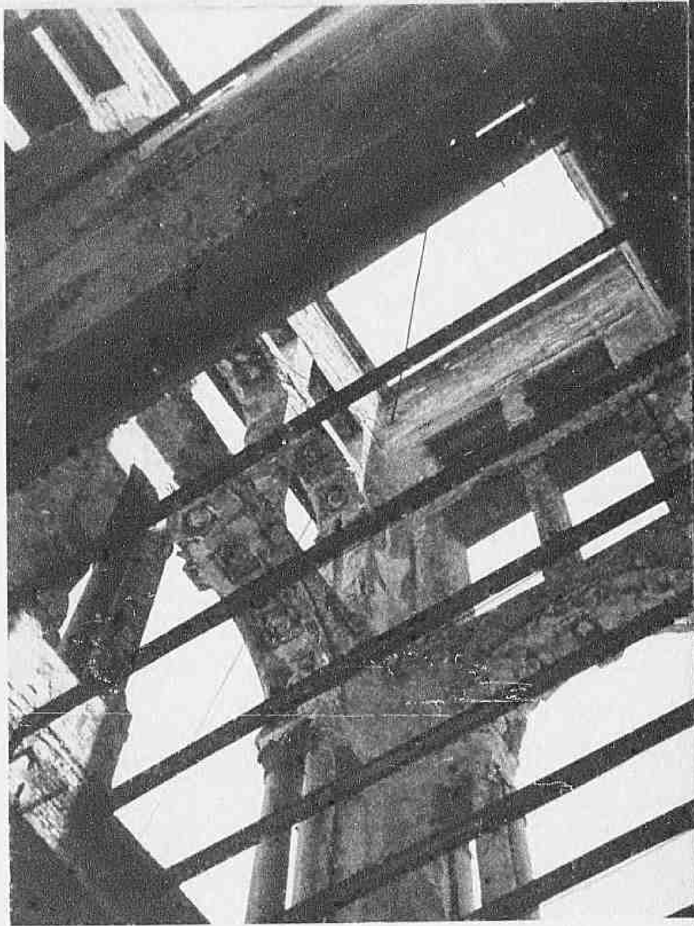
Il fuoco ha rivelato le grandi travi di legno che si elevano dietro le mura di mattoni di Giuseppe Mengoni nel centro di Milano nella seconda metà dell'800.
